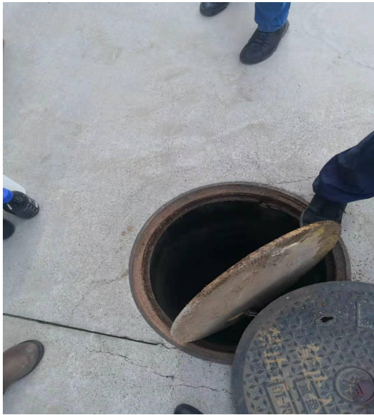
项目西侧生活污水排放口
